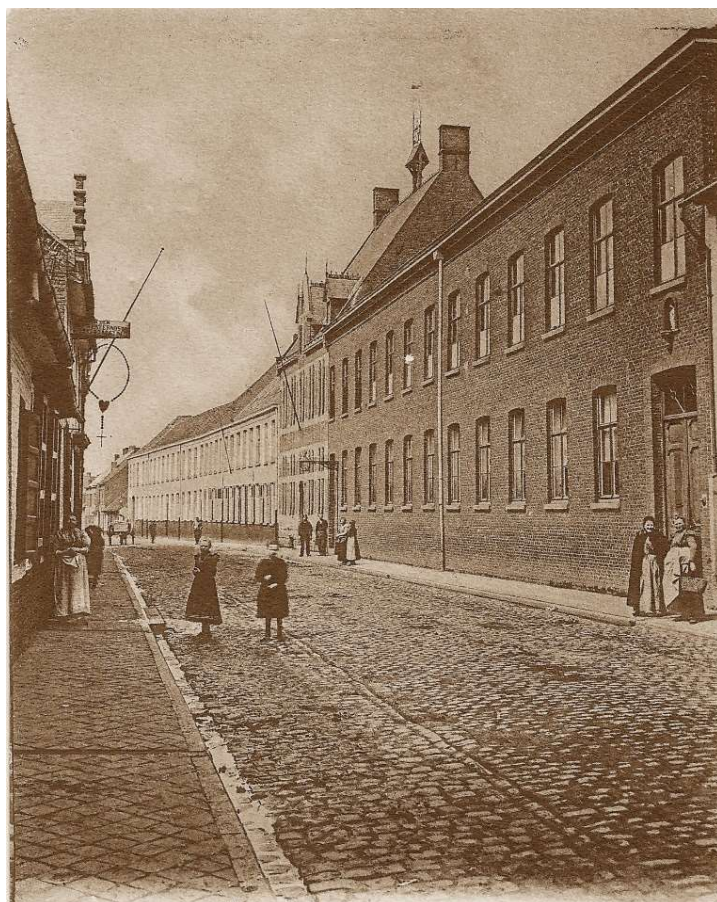
De Albrecht Rodenbachstraat – periode na de Wederopbouw bron: Filip Bommaré (ouder VCSR Rodenbachstraat)
